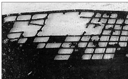
Bild 6: Nach fünf Jahren in einem PKW war der Stromableiter der positiven Elektrode durch Gitterkorrosion zerfressen. Quelle [12]
